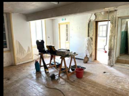
Le Vestiaire en travaux
