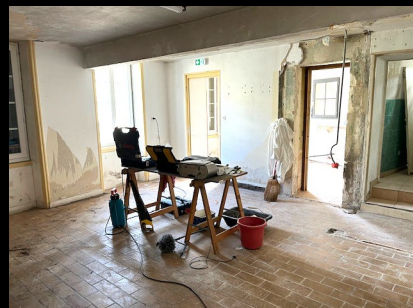
Le Vestiaire en travaux
